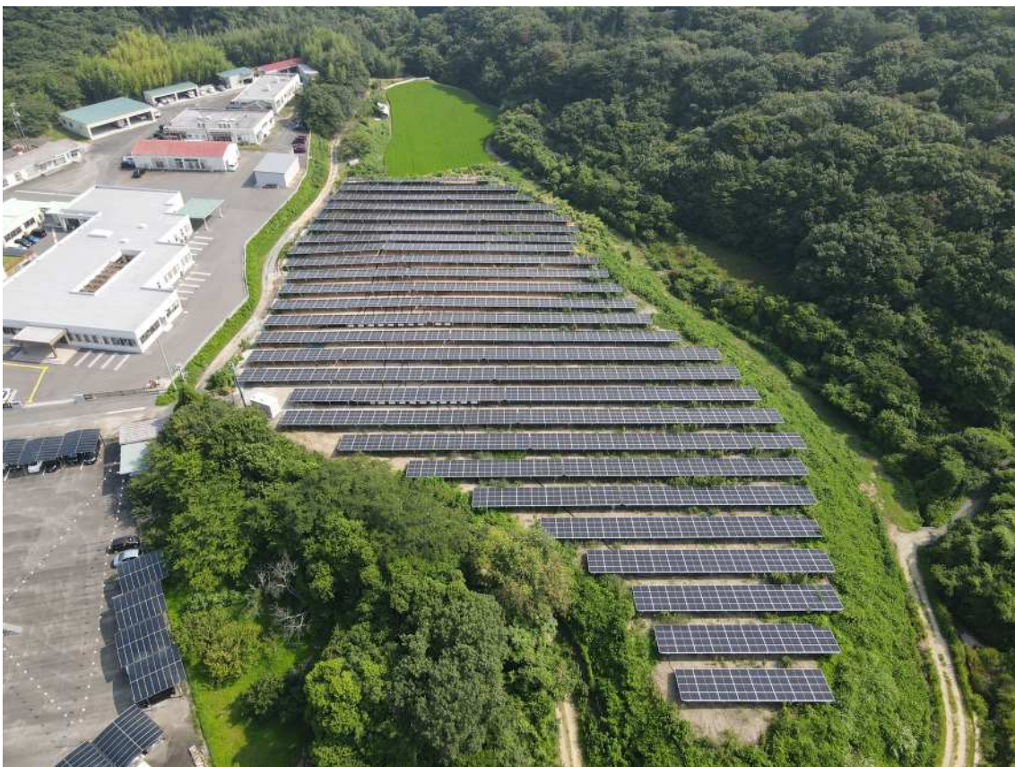
(イメージ)プロジェクトNo.13 宇部川上発電所
